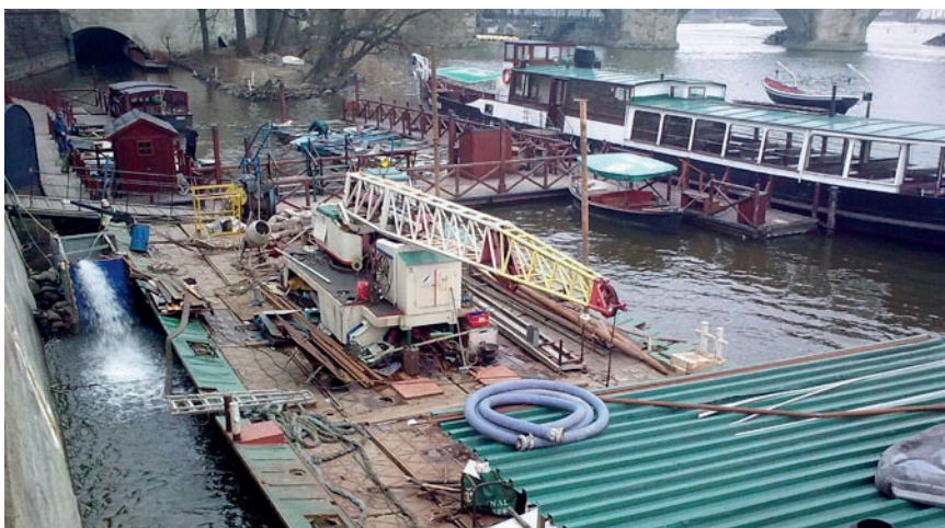
► Zařízení staveniště pro výstavbu přivaděče vody z Vltavy
