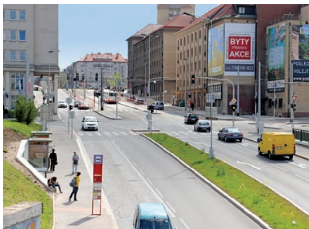
◀◀ Signalizovaný přístup na tramvajové zastávky s odsazeným nesignalizovaným koridorem přes trať
