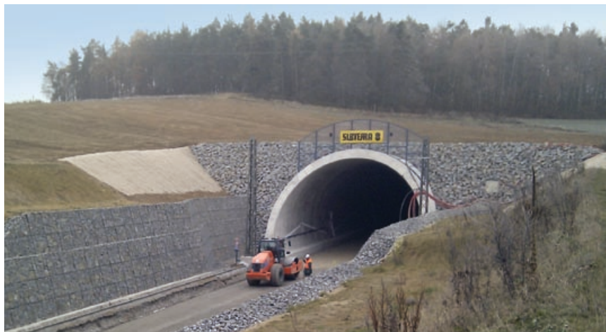
► Výjezdový portál tunelu
