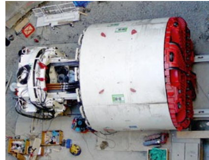
◀ Montáž štítu v šachtě na staveništi BRE 1
