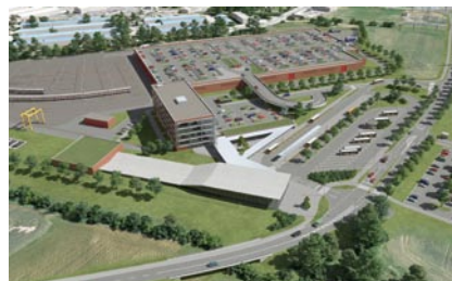
◀ Metro I.D: stanice Písnice
