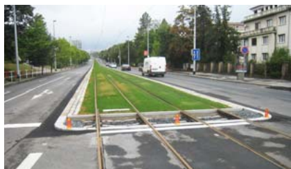
►► Pokládka betonového podkladu na tramvajové zastávce Thákurova – směr z centra
