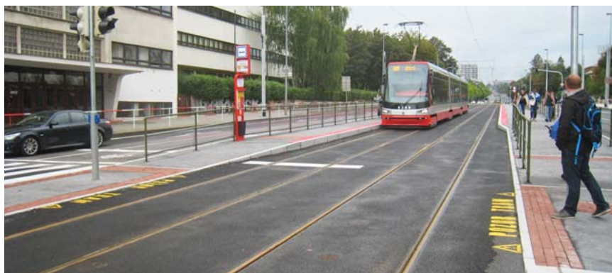
► Tramvajová zastávka po rekonstrukci – pohled směrem z centra
