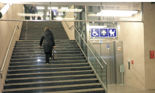
▲ Nástup do výtahu z úrovně nástupiště
