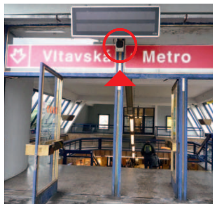
◀ Metro, majáček na prosklené stěně na vstupu. Panel s běžícím textem (nad majáčkem) slouží zejména sluchově postiženým (informace o mimořádných provozních stavech)
