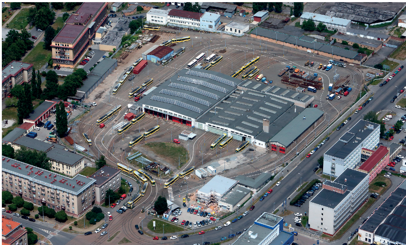
Pohled na vozovnu z dronu (2014)
